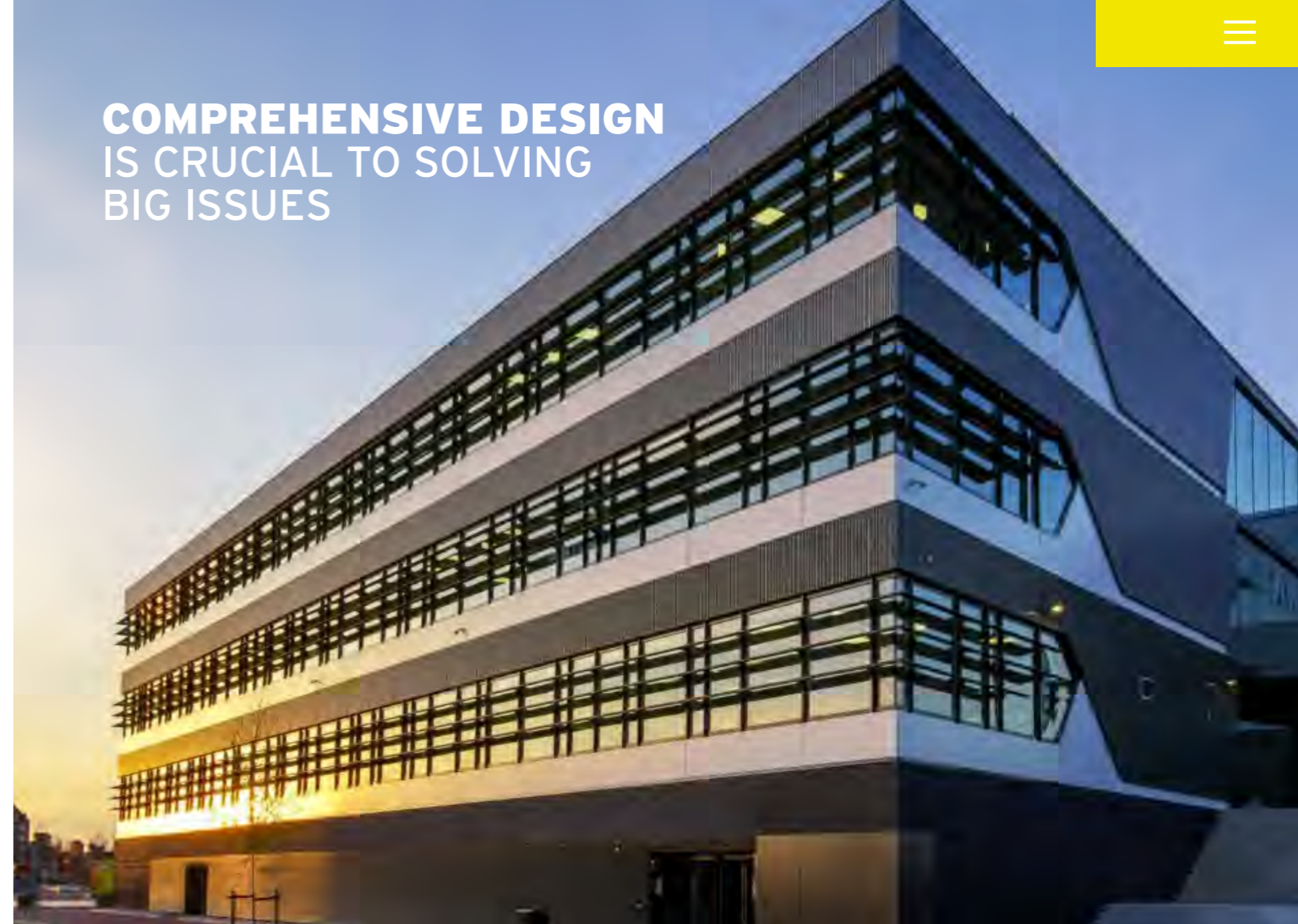
Nieuwbouw DuPont Leiden Bio Science Park
